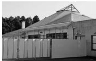
2024年11月 仮囲い設置
