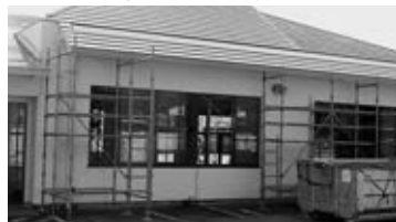
2024年12月 解体工事開始
